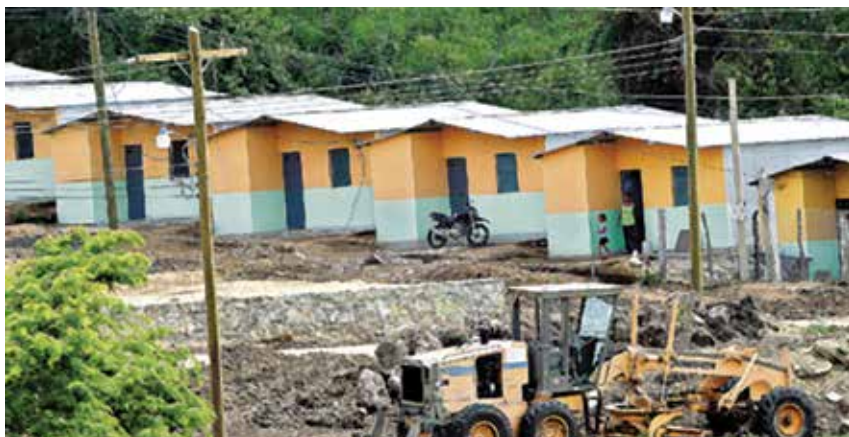
En Honduras, temen que el alza del cemento afecte los índices de construcción.
