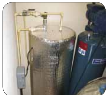
Water Heater Jacket. Cubierta de aislamiento térmico para tanques de agua caliente. Reduce la pérdida de calor hasta en un 40%.
