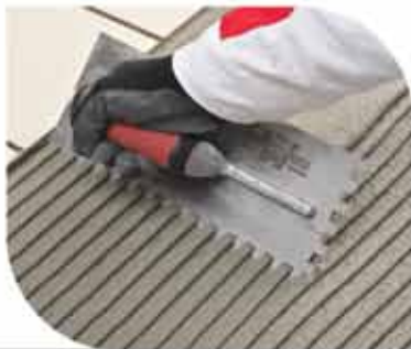
Instalación de Revestimientos Cerámicos y Minerales
