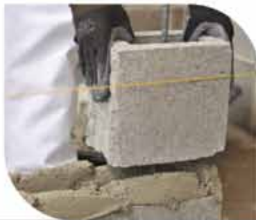
Construcción y Revestimiento de Paredes
