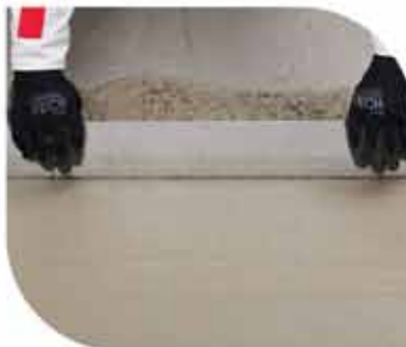
Nivelación y Protección de Pisos
