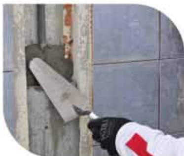
Reparación de Concreto y Anclajes
